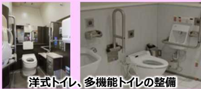
洋式トイレ、多機能トイレの整備
